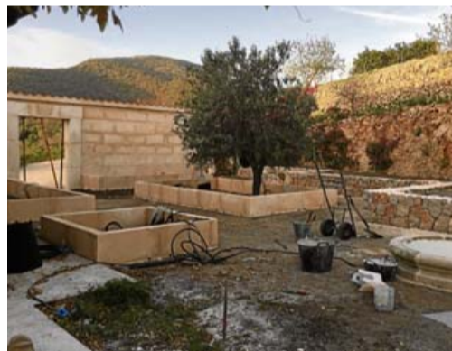
■ Die Arbeiten auf dem ehemaligen Parkplatz.
